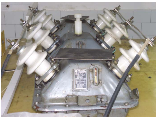
Рисунок 2.4 – Трансформаторы ОМ-125/10-71У1
