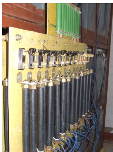
Рисунок 2.6 – Блок зарядных резисторов
