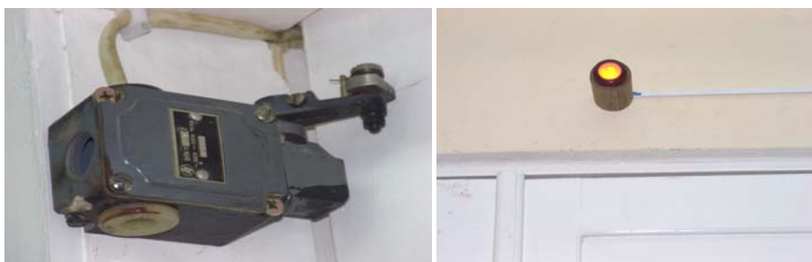
Рисунок 2.17 – Концевой выключатель и сигнальная лампа
